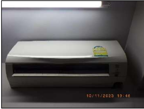
รูปที่ 26 อุปกรณ์ไฟฟ้า โดยเลือกใช้อฉลากประหยัดไฟฟ้าเบอร์ 5
