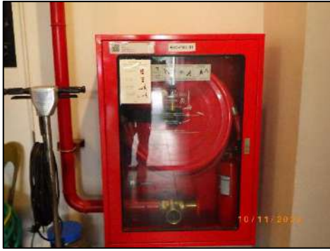
ตู้เก็บสายฉีดน้ำดับเพลิง
