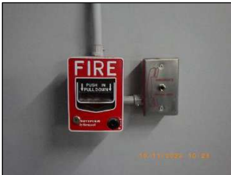
ปุ่มกดแจ้งสัญญาณอัคคีภัยแบบแจ้งเหตุด้วยมือ
