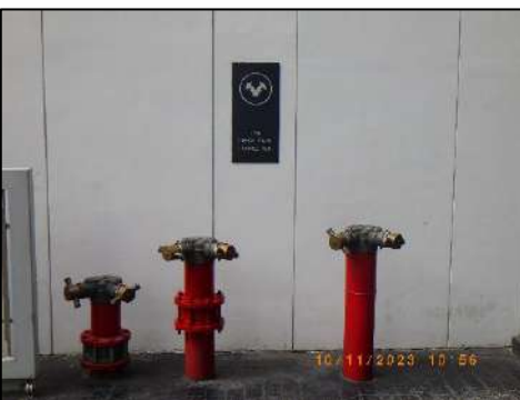
หัวสำหรับรับน้ำจากระบบดับเพลิง บริเวณอาคาร A
